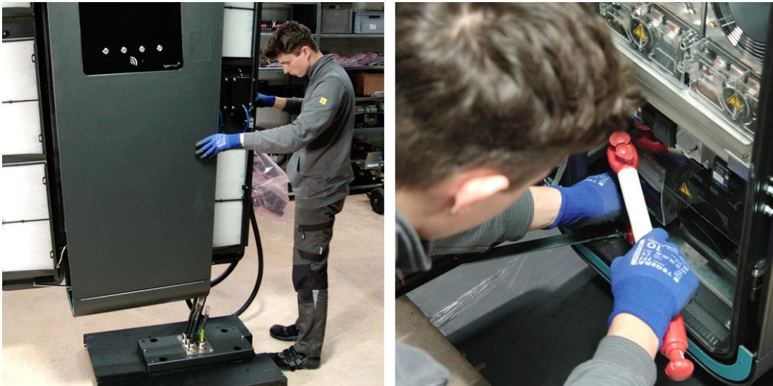
Abbildung 48: Positionierung HYC400 auf Sockel und Befestigung
