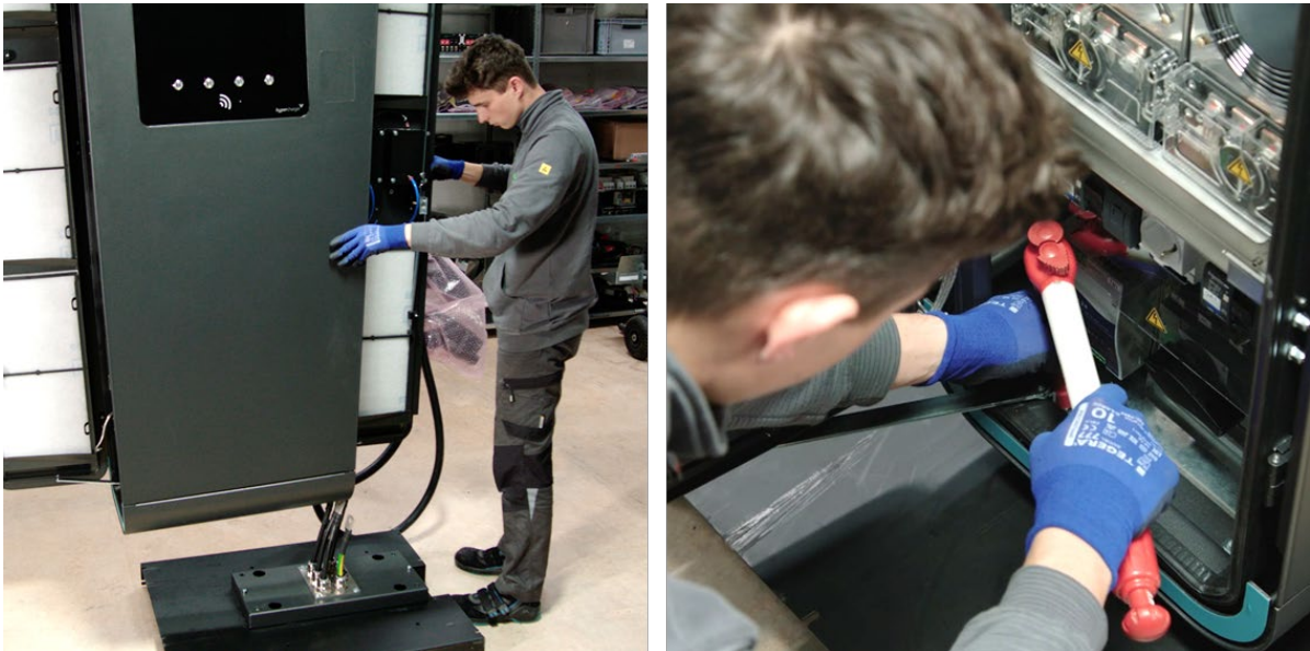
Abbildung 54: Positionierung HYC200 auf Sockel und Befestigung
